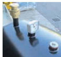
Механический уровнемер и фильтр на основе активированного угля. Mechanical level gauge and activated carbons vent filter.
